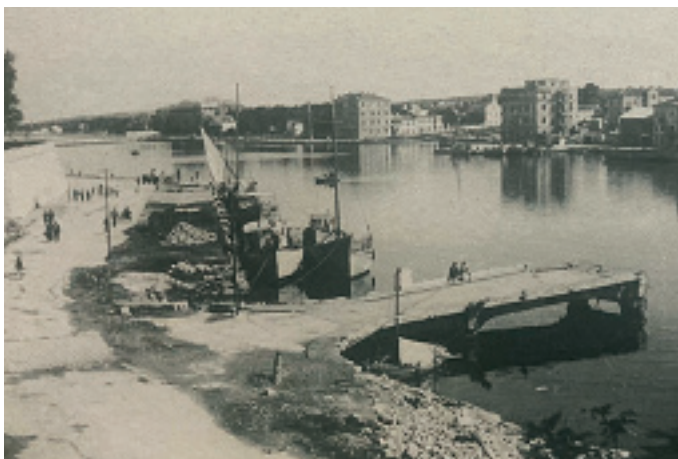
Zara. Il Ponte di Ceraria nel 1930 e il moncone rimasto dopo i bombardamenti
