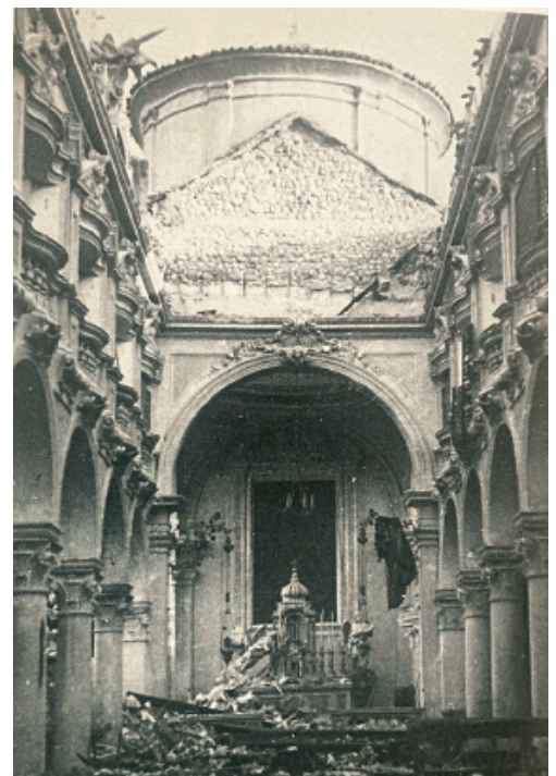
Interno della chiesa di Santa Maria, integro e dopo la distruzione fatta dalle bombe
